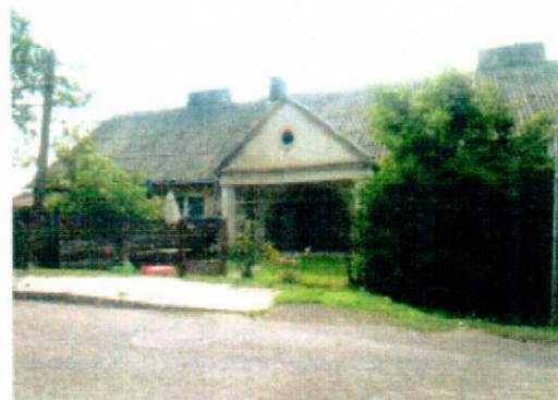
Wejście do budynku
